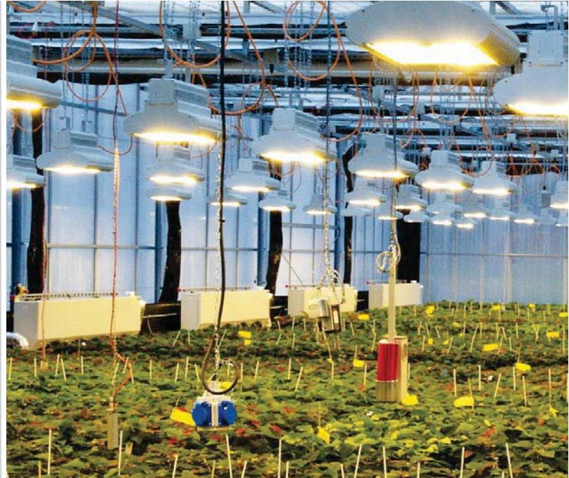
Pflanzenanzuchtleuchte aus extrudiertem Aluminium in Schutzart IP23. Ausgezeichnete mechanische Festigkeit und hohe Korrosionsbeständigkeit, wärmegeschützter Einbau aller Komponenten.
