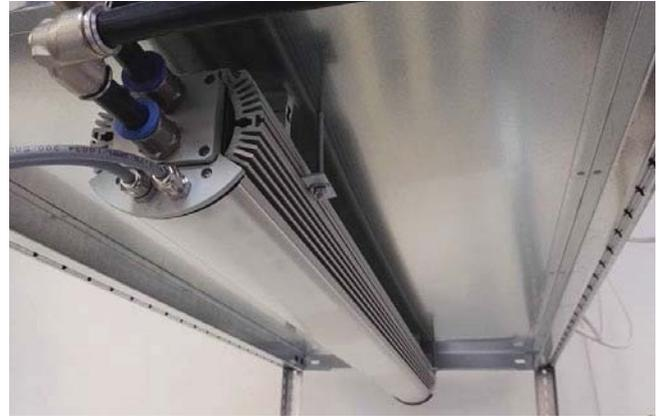
Die hier abgebildete LED-LE verfügt über einen Wasservor- und rücklauf. Dadurch ist die Leuchte aktiv mit einer Wasserdurchflusskühlung gekühlt. Im Laufe der Planung wird, angepasst auf die jeweilige Situation, eine Berechnung der Durchflussmenge für eine optimale Kühlung durchgeführt. Auch die Wassertemperatur spielt hier schon eine Rolle und wird berücksichtigt.
